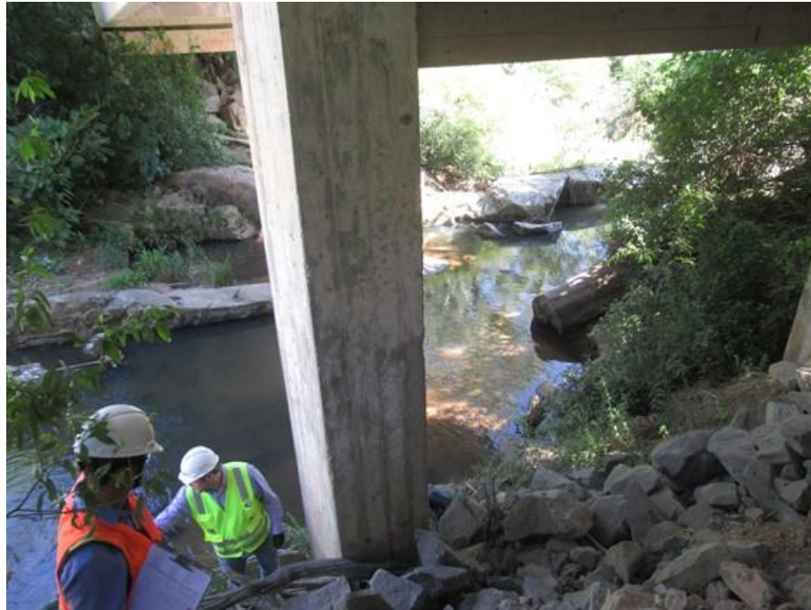
Foto 47 (IMG_0814) Pilar oeste – Apoio 1.
