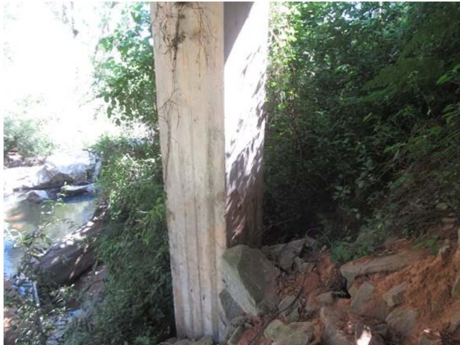
Foto 48 (IMG_0819) Pilar leste – apoio 1.
