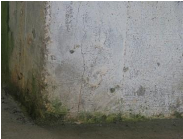
Foto 26: Pilar oeste – Apoio 2.
