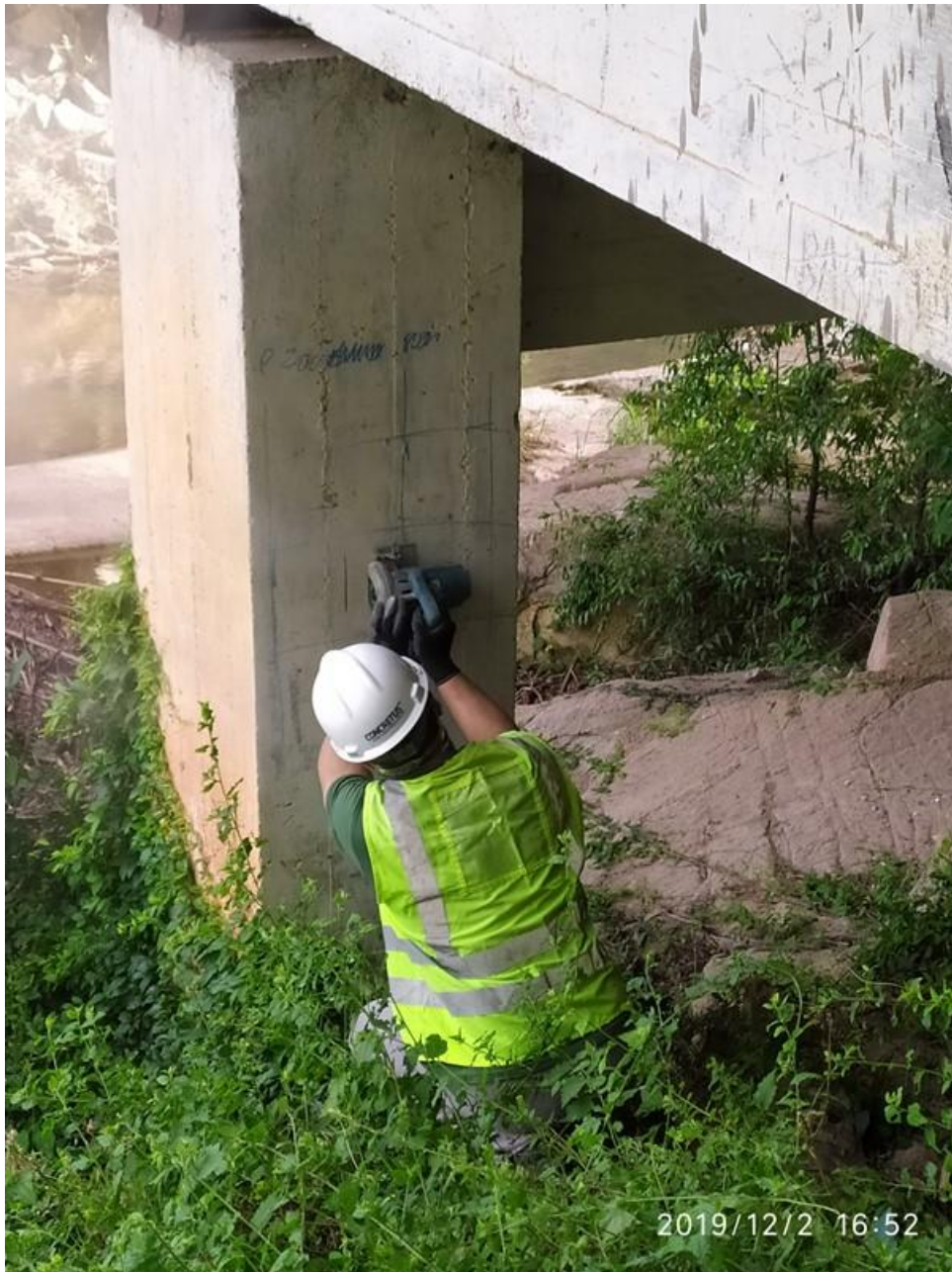
Foto 2: Corte para ensaio de carbonatação – Pilar Leste – Apoio 2.
