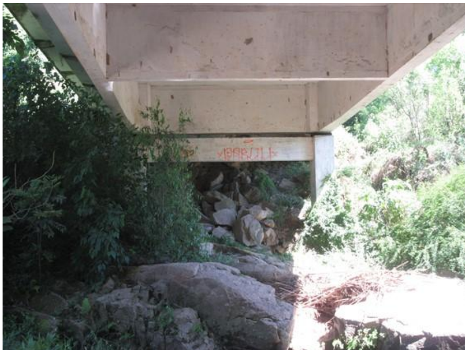
Foto 20 (IMG_0862): Apoio 2 (Norte) – Vista Sul/Norte.
