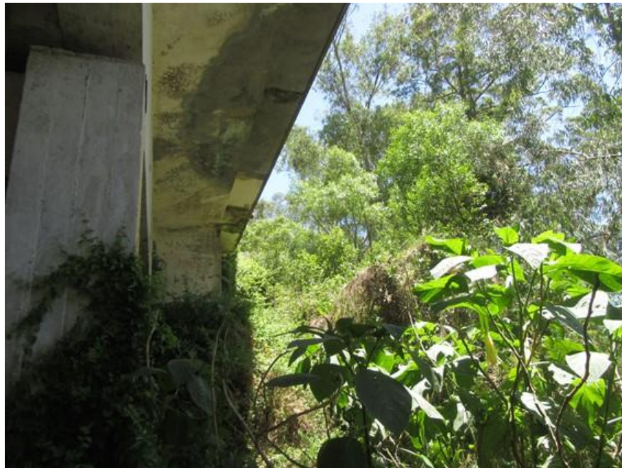
Foto 83 (IMG_0964) Cortina 2 (Norte) – Talude leste.
