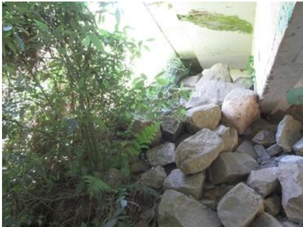
Foto 34: Talude lateral oeste – Encontro norte.
