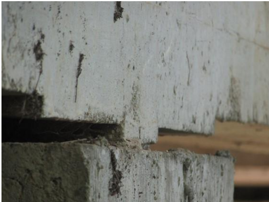
Foto 70 (IMG_0883) Aparelho de apoio – Pilar leste – Apoio 1 (Sul) – Tipo Freyssinet.
