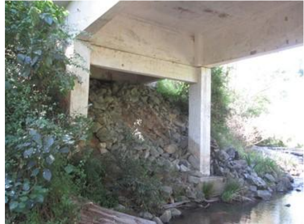
Foto 33: Talude lateral Leste – encontro sul.
