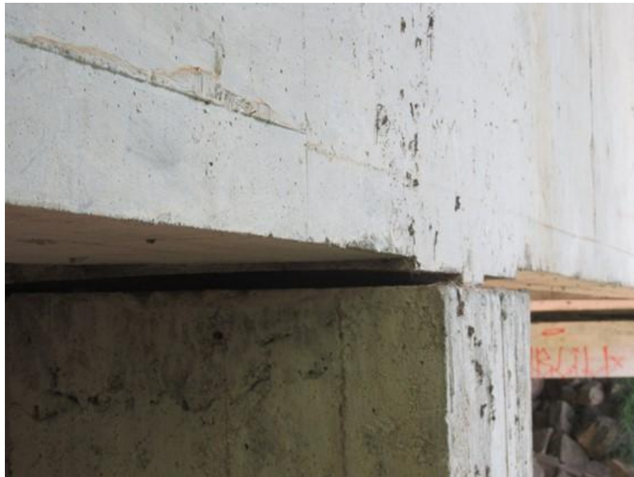
Foto 71 (IMG_0884) Aparelho de apoio – Pilar leste – Apoio 1 (Sul) – Tipo Freyssinet.
