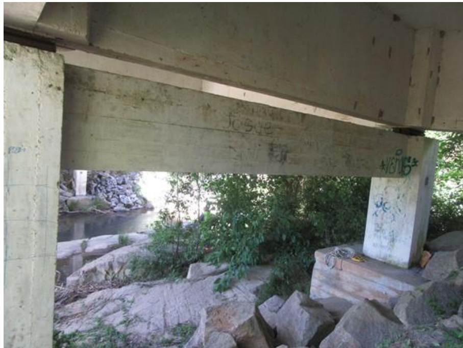
Foto 49 (IMG_0936) Apoio 2 – face norte.
