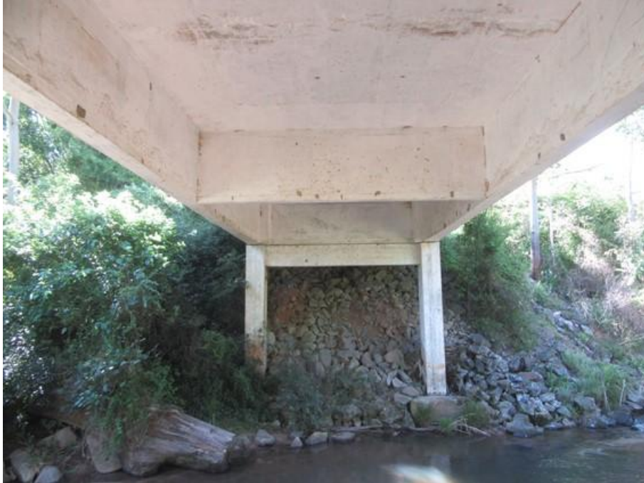
Foto 1 – Sistema estrutural da ponte.
