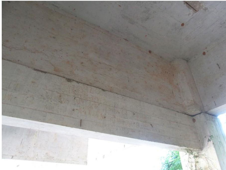
Foto 29 (IMG_0820): Transversina 2 e Travessa 1 - face sul.
