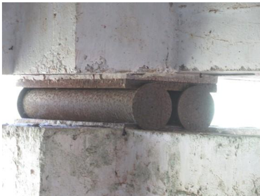
Foto 74 (IMG_0955) Aparelho de apoio – Pilar Leste – Apoio 2 (Norte) – Tipo rolete metálico.
