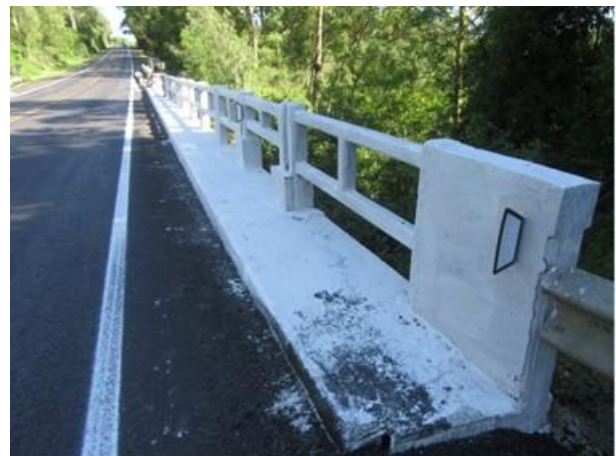
Foto 43: Guarda Corpo Oeste – Bom estado.
