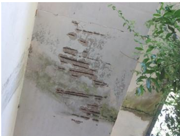
Foto 10: Balanço Oeste – Vista Norte/Sul – Mancha de Umidade e armadura exposta.
