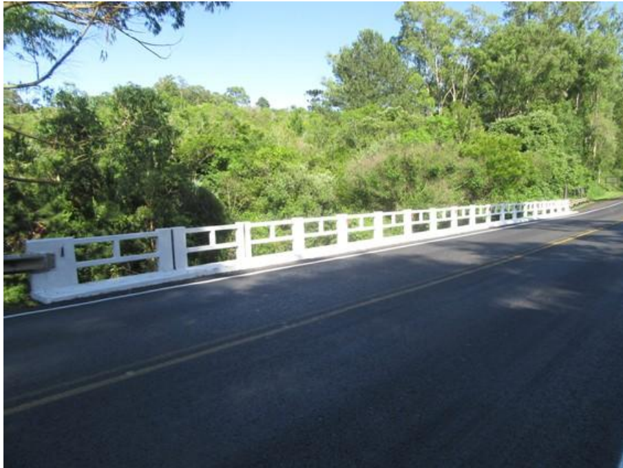
Foto 05 (IMG_0753): Junta de dilatação Sul – Recoberta por pavimento..
