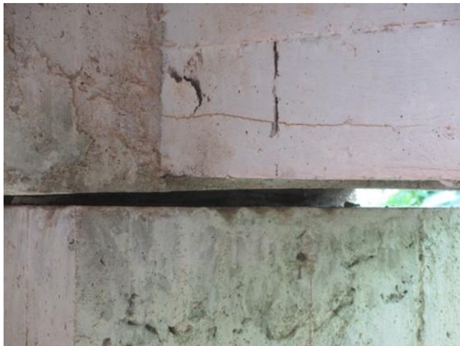
Foto 72 (IMG_0879) Aparelho de apoio – Pilar oeste – Apoio 1 (Sul) – Tipo Freyssinet – Vista interna.
