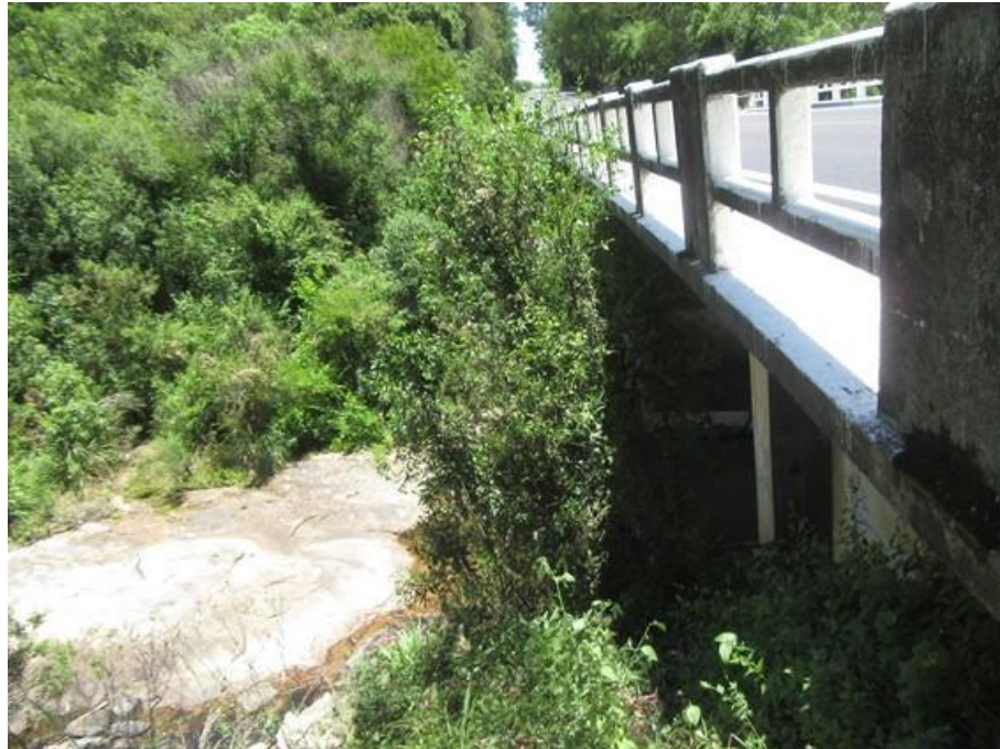
Foto 87 (IMG_0998) Vista face oeste – Sul/Norte.
