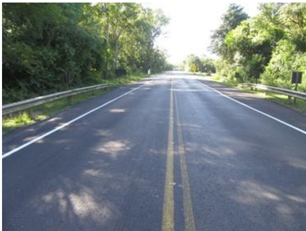
Foto 6: Aproximação sul - vista Pelotas.
