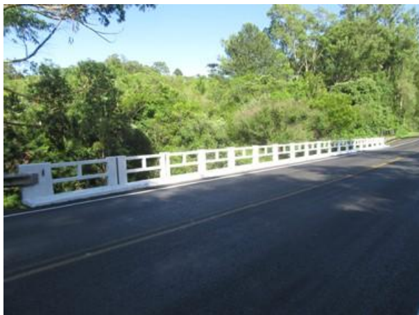
Foto 38: Pista de rolamento – Sentido Santana da boa vista – Bom estado.
