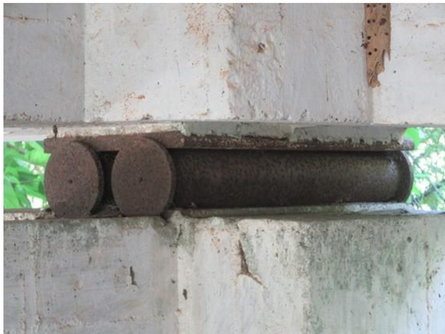
Foto 76 (IMG_0957) Aparelho de apoio – Pilar Oeste – Apoio 2 (Norte) – Tipo rolete metálico.
