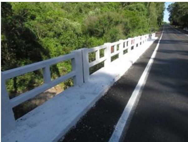
Foto 42: Guarda Corpo Leste – Bom estado.
