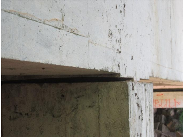
Foto 2: Aparelho de apoio tipo Freyssinet.
