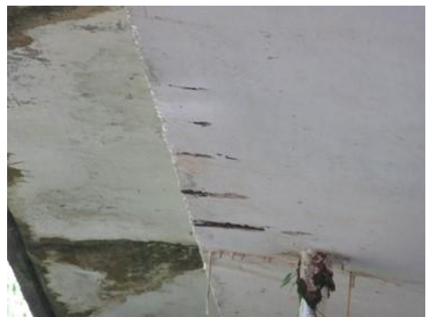
Foto 11: Balanço Leste – Vista Norte/Sul – Mancha de umidade.
