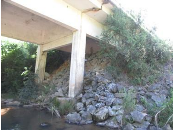
Foto 32: Talude lateral Leste – encontro sul.
