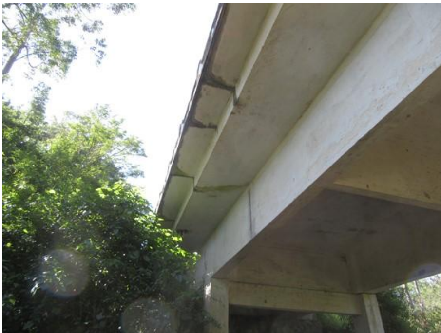
Foto 56 (IMG_0786) Balanço leste – Vista Apoio 1.
