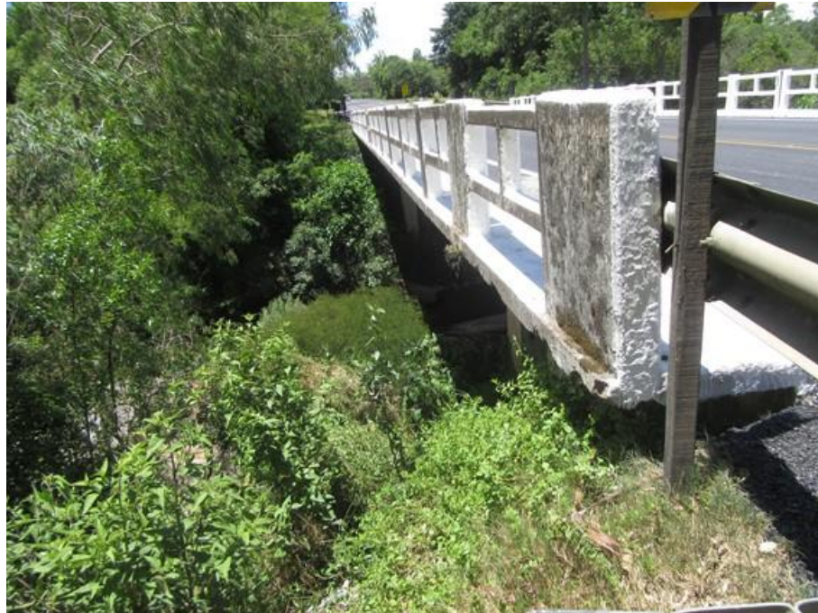
Foto 85 (IMG_0996) Vista face leste – Norte/Sul.
