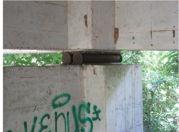
Foto 3: Aparelho de apoio tipo rolete metálico.
