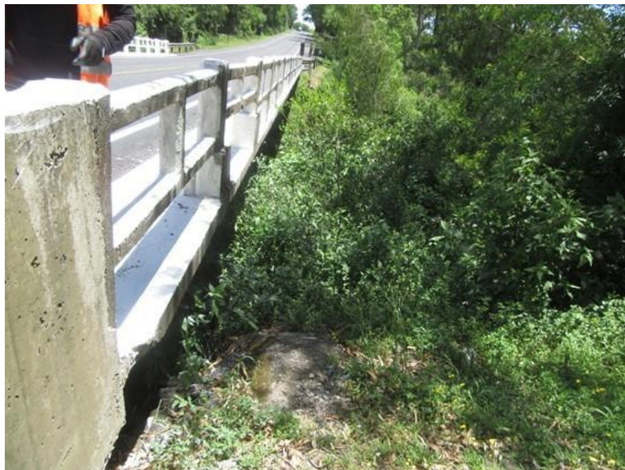
Foto 88 (IMG_1000) Vista face leste – Sul/Norte.
