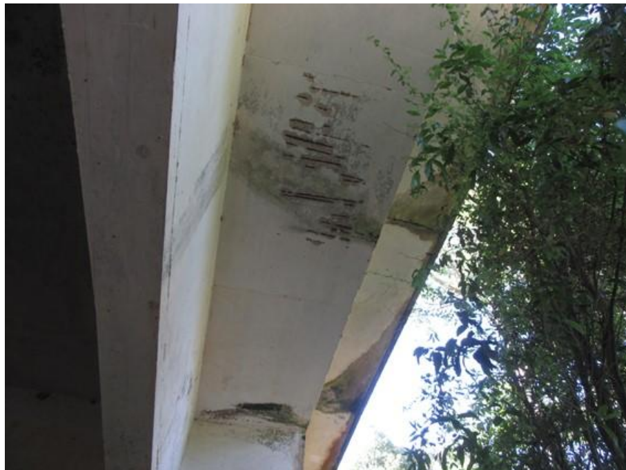
Foto 64 (IMG_0799) Balanço Leste – Vista Encontro 1 (sul).
