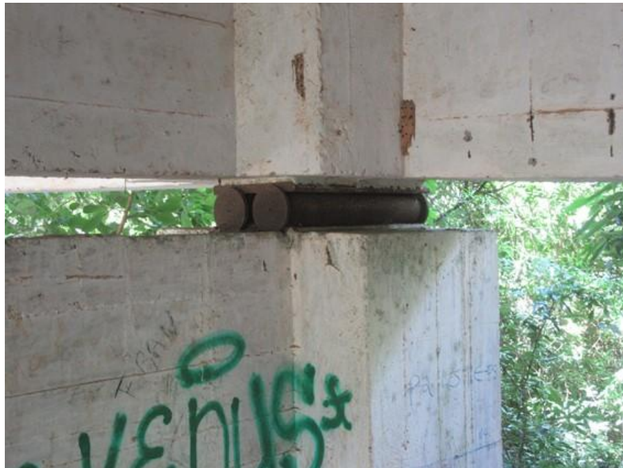
Foto 75 (IMG_0956) Aparelho de apoio – Pilar Oeste – Apoio 2 (Norte) – Tipo rolete metálico.
