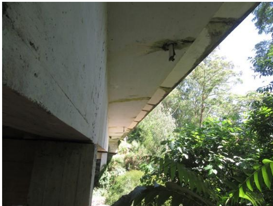
Foto 60 (IMG_0887) Balanço leste – Vista Sul/norte.
