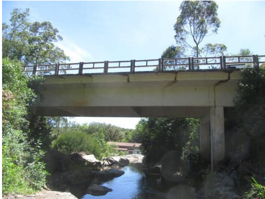
Foto 01 (IMG_0902): Vista lateral Oeste da OAE.
