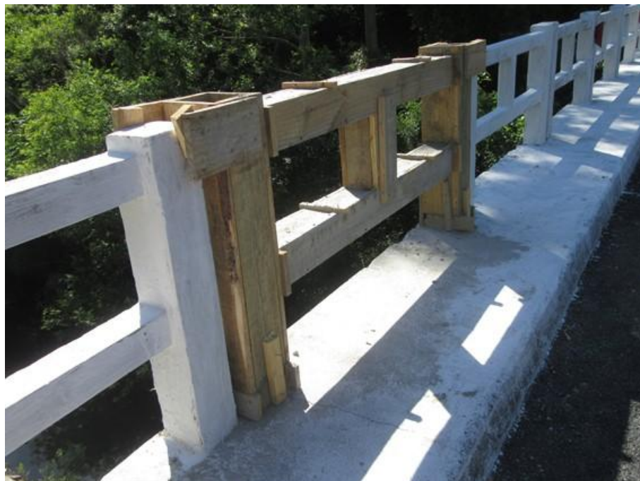
Foto 10 (IMG_0780): Reparo – Guarda corpo leste.
