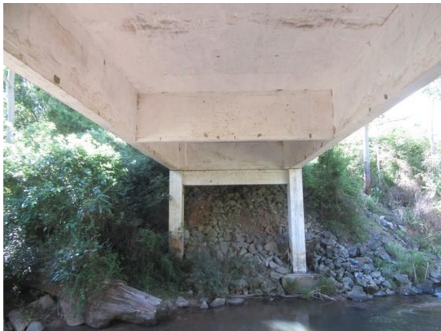
Foto 18 (IMG_0782): Apoio 1 (sul) – Vista Norte/Sul.
