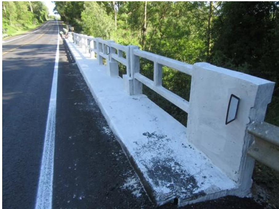
Foto 07 (IMG_0766): Guarda Corpo Leste.
