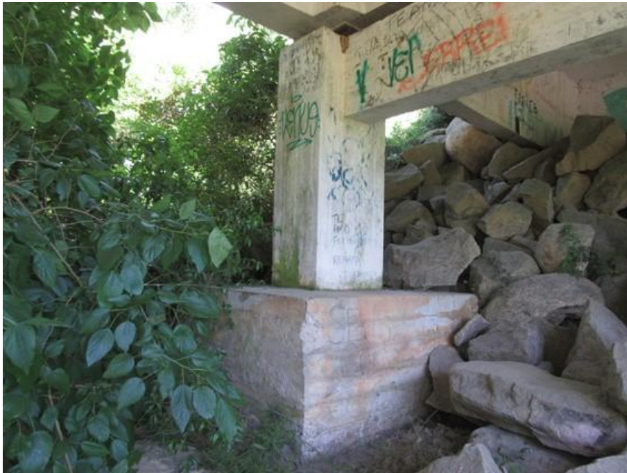
Foto 5: Bloco de fundação Apoio 2 pilar oeste.
