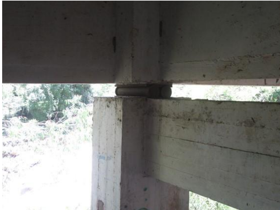
Foto 73 (IMG_0954) Aparelho de apoio – Pilar Leste – Apoio 2 (Norte) – Tipo rolete metálico.
