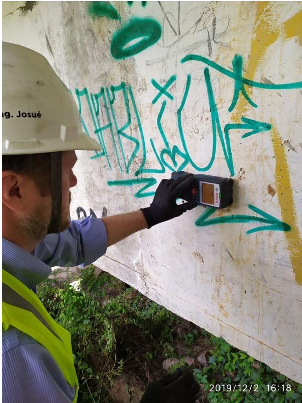
Foto 1: Execução de pacometria – Viga Longarina Leste – Balanço 2.
