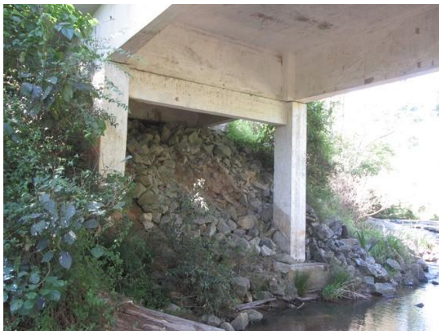
Foto 16 (IMG_0792): Apoio 1 (norte) – Vista Oeste/Leste.
