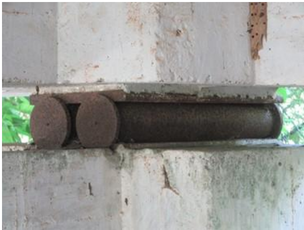
Foto 24: Aparelho de apoio do tipo rolete metálico - Apoio 2 Leste.
