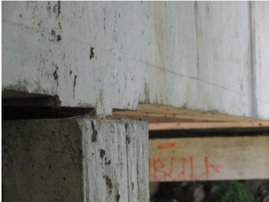
Foto 69 (IMG_0881) Aparelho de apoio – Pilar leste – Apoio 1 (Sul) – Tipo Freyssinet.
