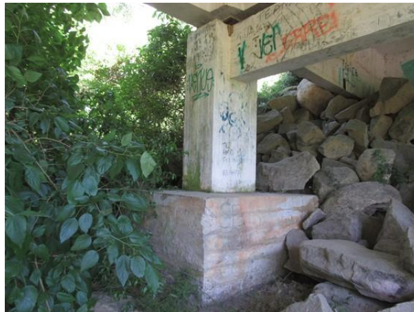
Foto 31: Bloco de fundação - Apoio 2 oeste.
