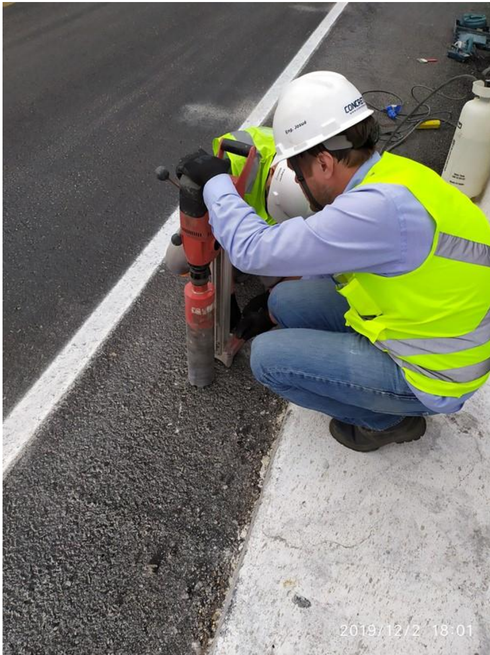
Foto 2: Execução de furo de prospecção – Balanço 2 (Norte).
