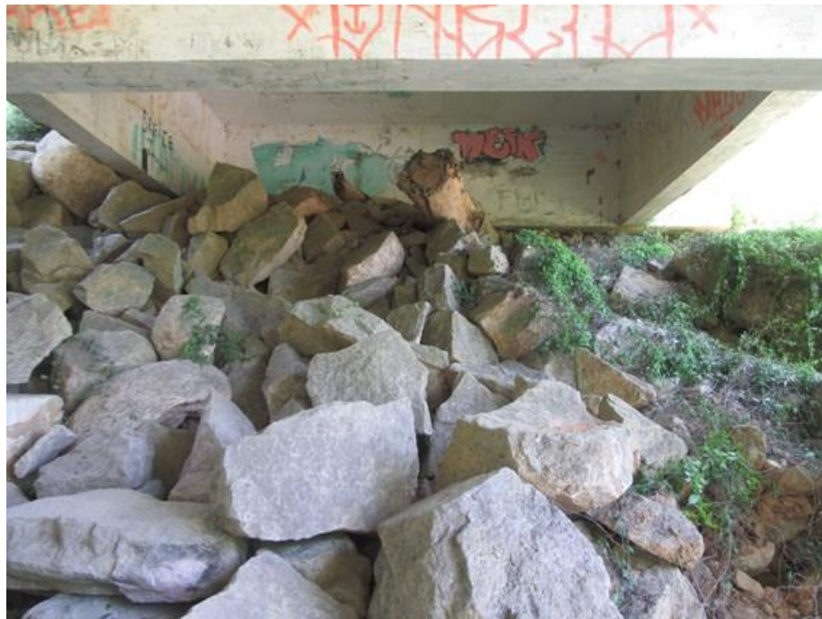
Foto 81 (IMG_0960) Cortina 2 (Norte) – Talude sob obra.
