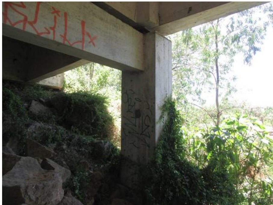
Foto 50 (IMG_0938) Pilar leste – apoio 2.
