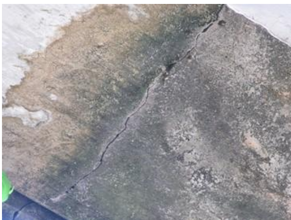
Foto 10: Balanço Oeste – Vista Norte/Sul – Mancha de Umidade e armadura exposta.
