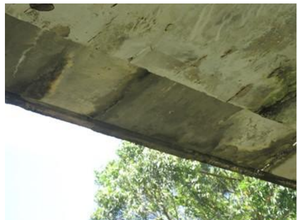
Foto 11: Balanço Leste – Vista Norte/Sul – Mancha de umidade.
