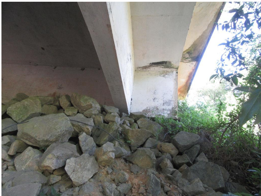
Foto 78 (IMG_0798) Talude oeste – Cortina 1 (sul).
