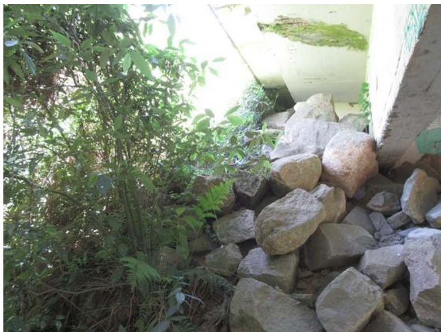
Foto 82 (IMG_0961) Cortina 2 (Norte) – Talude oeste.
