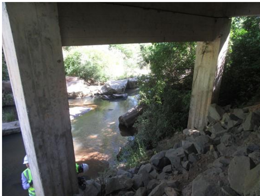
Foto 46 (IMG_0812) Apoio 1 –face sul.
