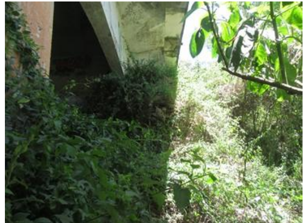
Foto 35: Talude lateral leste – Encontro norte.
