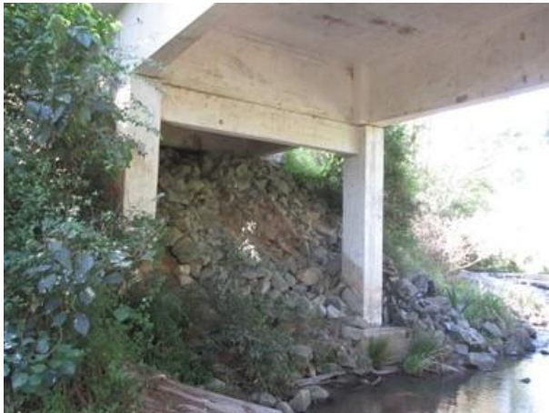
Foto 36: Talude sob obra - Encontro sul.
