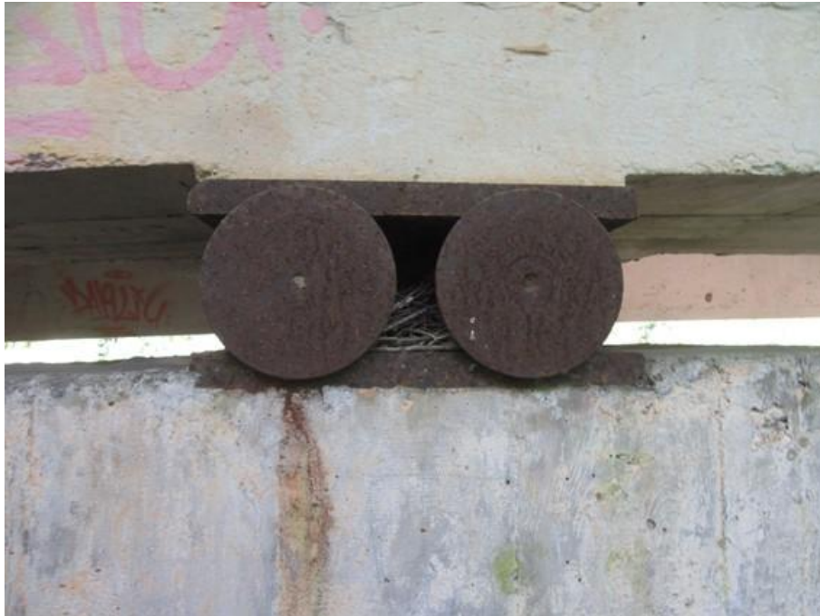
Foto 77 (IMG_0958) Aparelho de apoio – Pilar Oeste – Apoio 2 (Norte) – Tipo rolete metálico.
