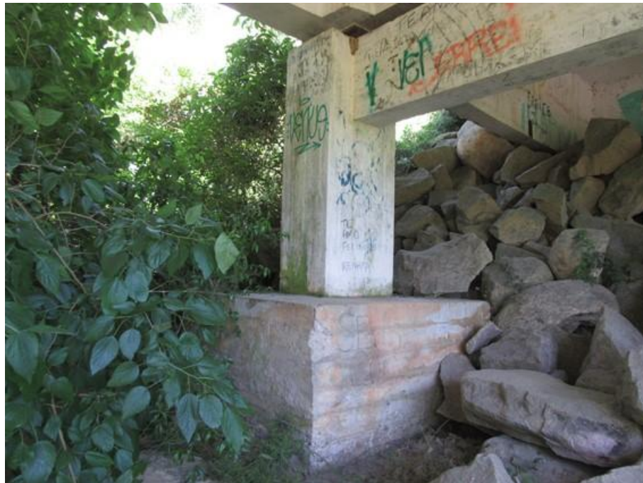
Foto 51 (IMG_0940) Pilar oeste – Apoio 2.
