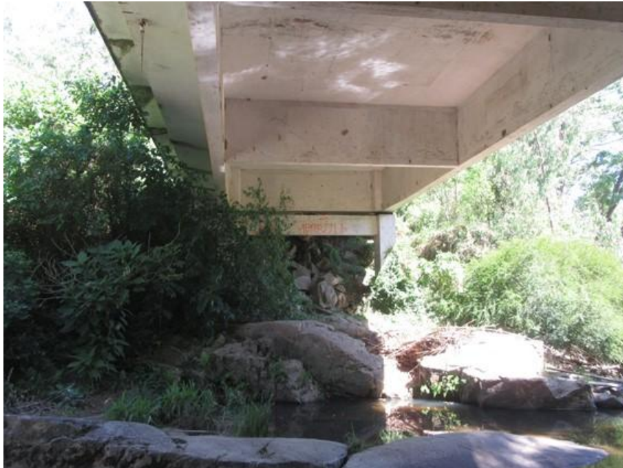
Foto 19 (IMG_0861): Apoio 2 (Norte) – Vista Sul/Norte.
