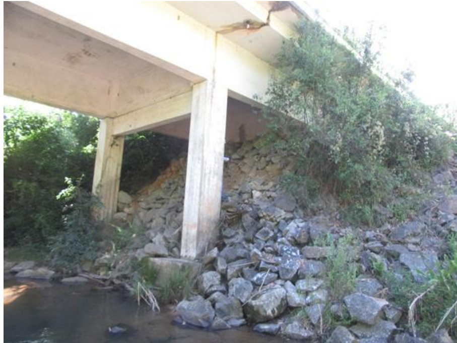
Foto 17 (IMG_0795): Apoio 1 (sul) – Vista Leste/Oeste.
