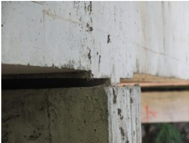
Foto 22: Articulação de concreto do tipo Freyssinet – Apoio 1 Leste.
