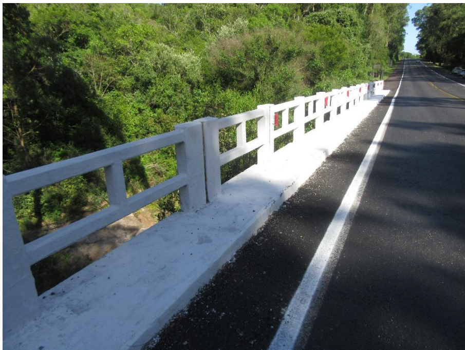
Foto 06 (IMG_0754): Guarda corpo oeste – Vista Sul/Norte.
