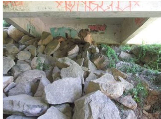
Foto 37: Talude sob obra – Encontro norte.
